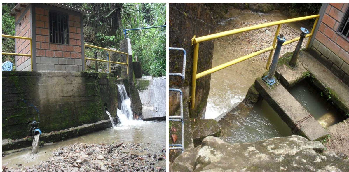
Foto 4. Canal de entrada y desarenador
